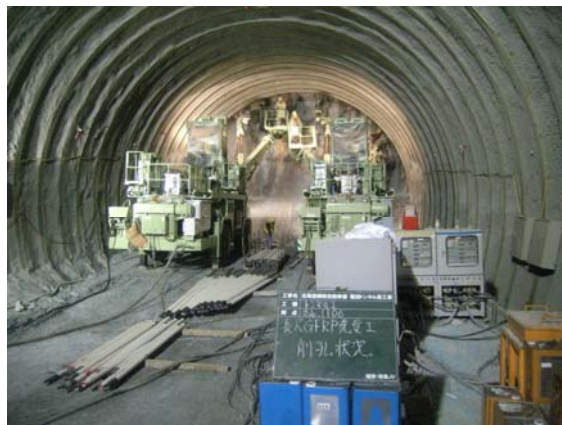
写真-1 補助工法施工状況
