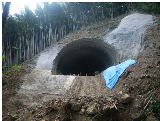
写真 1 河内トンネル貫通点側坑口部
