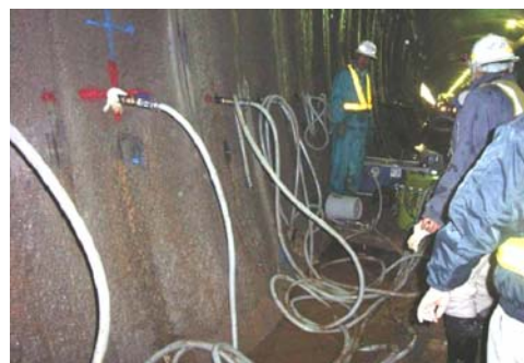
写真2 ウェルポイント実施状況
