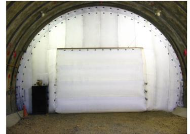
図-1 隔壁バルーン設置状況
