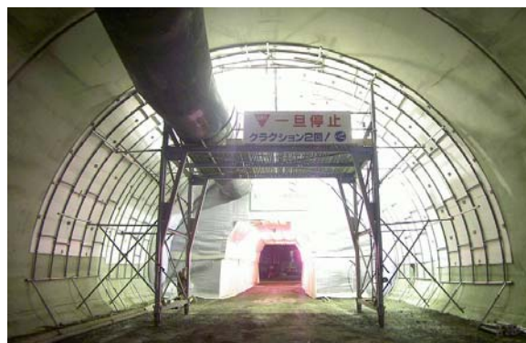
写真-1 覆工養生状況
