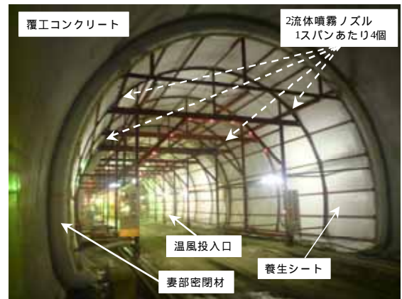
写真 - 1 連続養生システム全景
