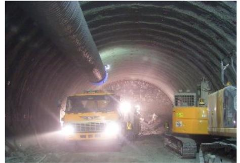
写真-1 吸引ダクトシステム稼働状況
