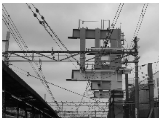
写真 4-1 柱ブロック立柱状況
