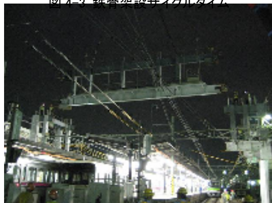
写真 4-4 大梁架設状況
