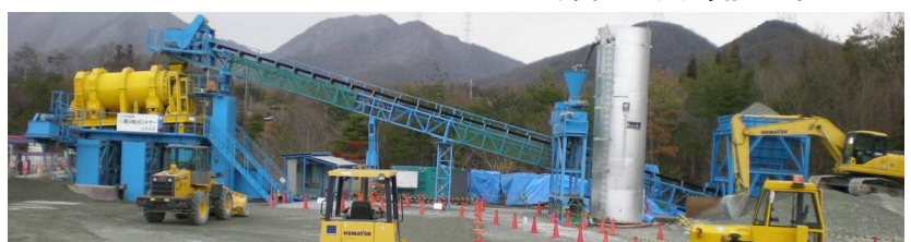
写真-3 CSG 混合プラント全景
