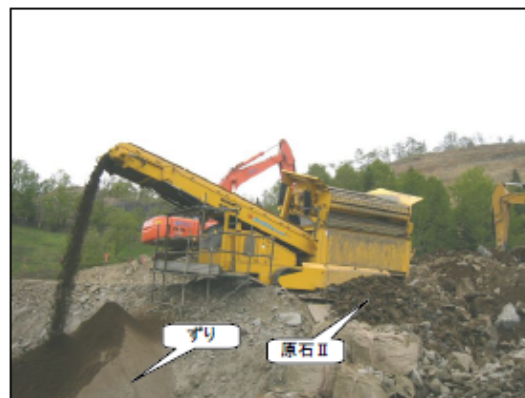
図-5 原石IIのずり抜き作業
