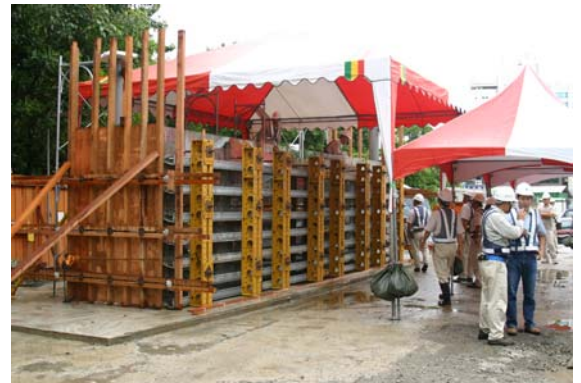
写真-1 実物大模型打設試験状況
