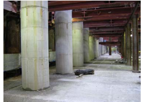
写真-1 場所打ち杭の2段階施工状況
