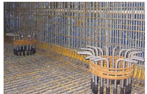
写真-2 機械継手による杭頭筋接合
