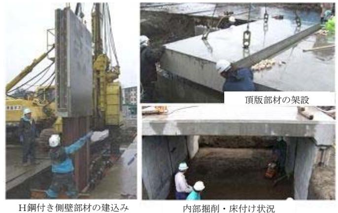
写真-1 施工性能試験状況
