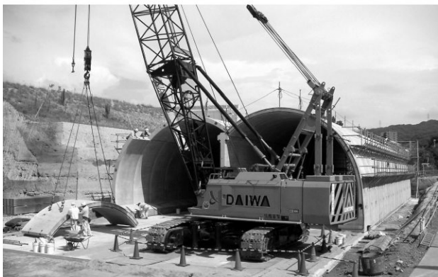
写真3 80t クローラークレーンによるモジュラーチ組立
