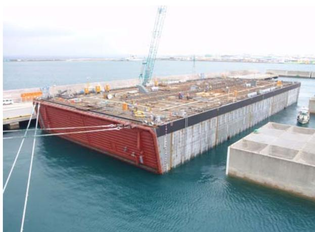
図-1 7号函体沈埋函係留状況
