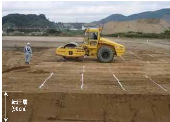
図-3 転圧・走行試験の状況(山砂購入土)
