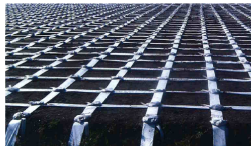
写真1 水平 PBD の布設例
