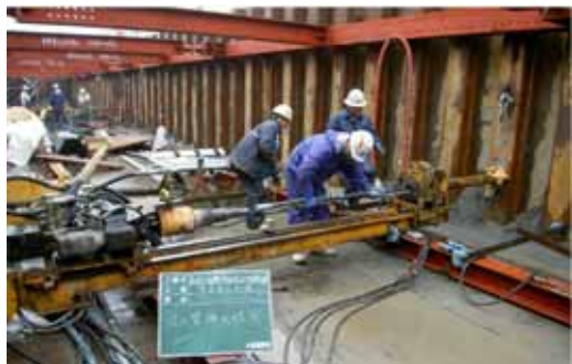
写真-1 水平削孔状況 (TK-8004)
