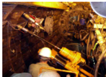
注入孔を利用して掘削
