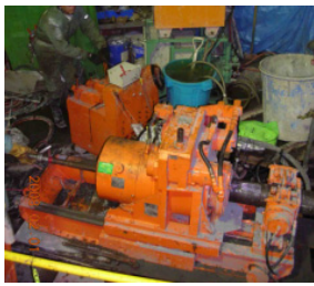
ボーリング機械設置
