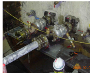
発振器設置孔掘削
