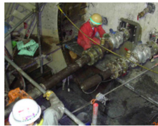
発振器挿入設置
