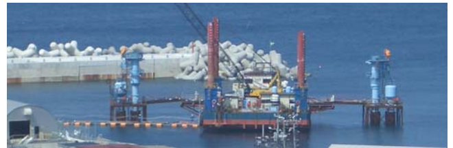
写真2 SEP作業台・艀装完了
