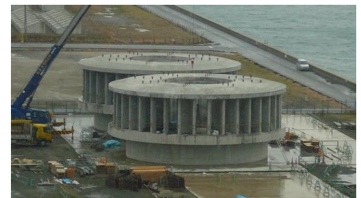
写真1 取水口ケーソン製作状況
