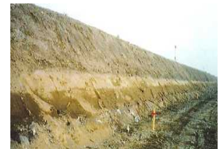
写真-2 サンドマット上に施工された運搬路
