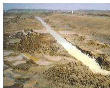
写真-3 運搬路脇の仮排水
