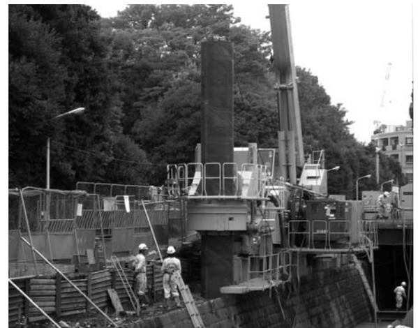
写真-1 鋼管杭圧入状況
