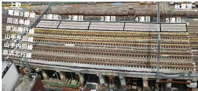
図-4 工事桁架設割付
