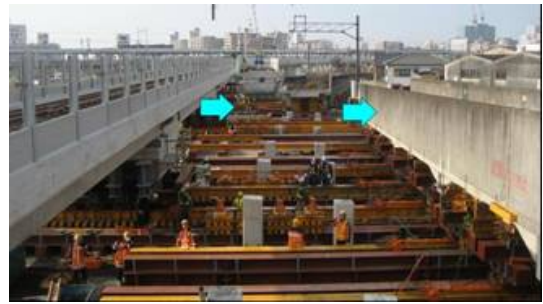
(写真-3 横取り施工状況)
