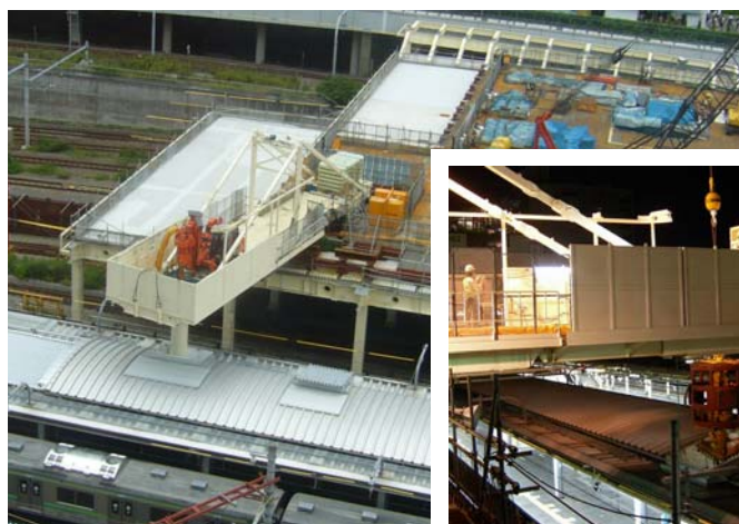
写真-2 ホーム上家の改造
