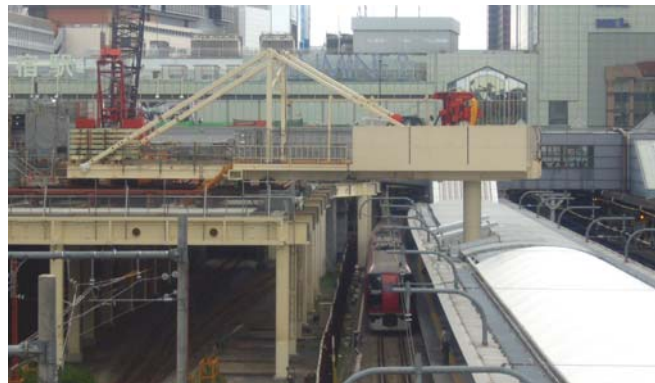
写真-1 ポータブルステージ設置状況
