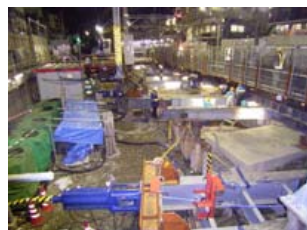
写真-3 ジャッキ配置状況
