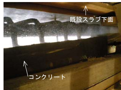
写真 2：スラブ先端のフロー確認状況
