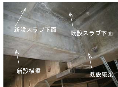
写真 3：一体化部の充てん確認状況
