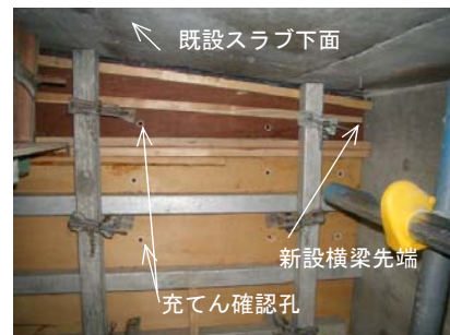
写真 1：充てん状況確認兼空気抜き孔設置状況
