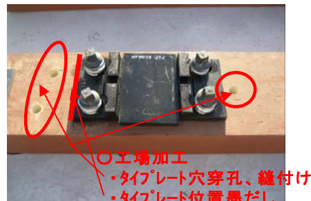
写真-2 マクギ穴工場加工
