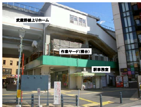
写真－2 作業構台（武蔵野線高架橋下）
