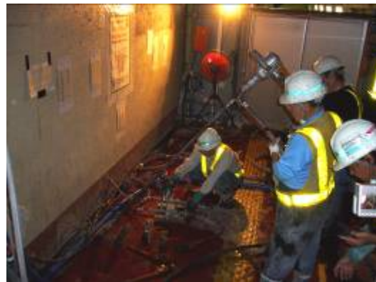
写真－３ ステージ注入工法
