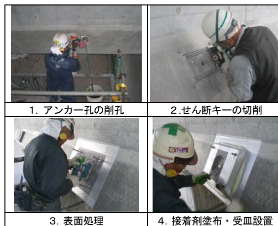
写真-2 ストラット受皿設置状況
