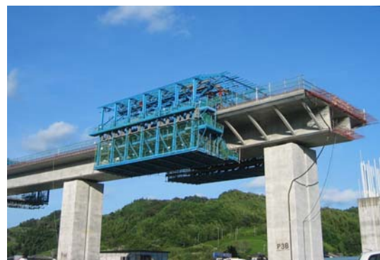
写真-1 拡幅作業車
