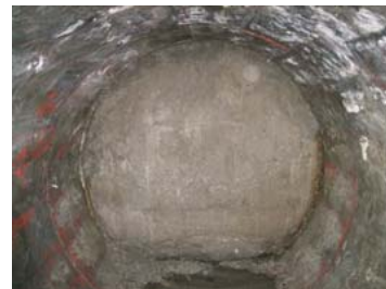
写真 5.3 露出した地山と流動化処理土
