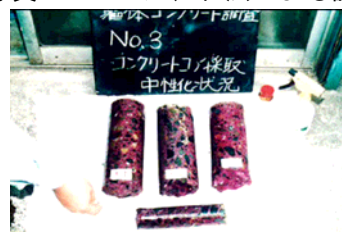
写真-4 フェノールフタレイン法による調査
