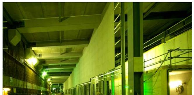
写真-1 現在の施工状況(梁・中壁の耐火パネル)
