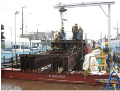
写真-1 吊り桁、吊り装置
