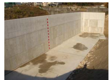
写真-2 完了全景
