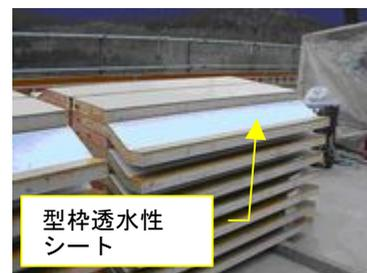
図-1 型枠透水性シート使用例
