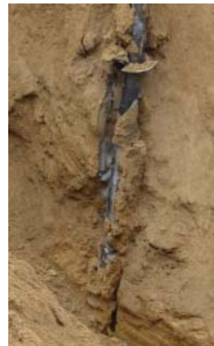
図-7 杭の掘出し状況
