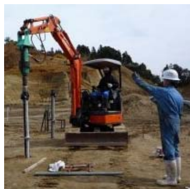
図-2 直杭 回転貫入作業状況
