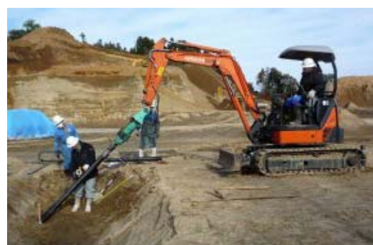
図-6 斜杭 回転貫入作業
