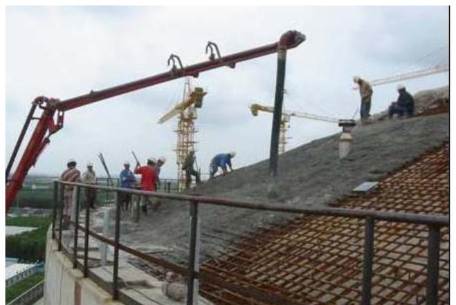
写真-4 屋根コンクリートの施工状況
