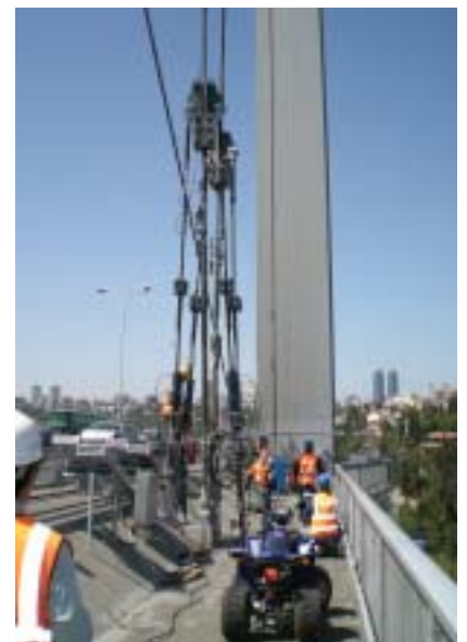
写真-1 ロングハンガー作業状況
