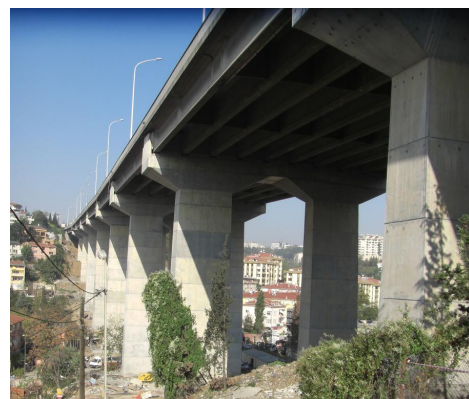
写真-1 補強後の橋梁
