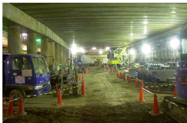
写真-1 PCR下掘削状況
