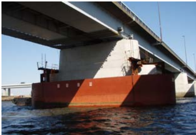
写真－1 仮締切設置状況
