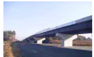
写真 - 1 全工区架設完了
