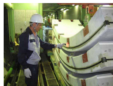
写真-3 組立履歴情報の読み取り状況（切羽）
