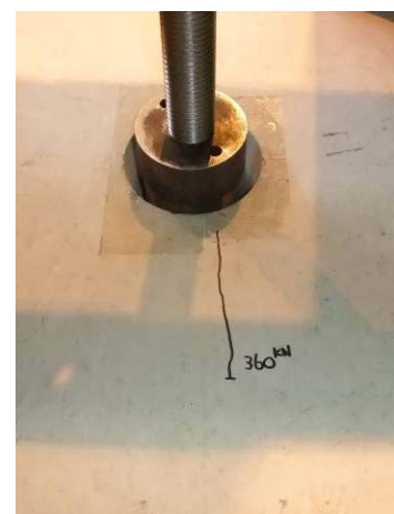
写真－３．ひび割れ発生状況
