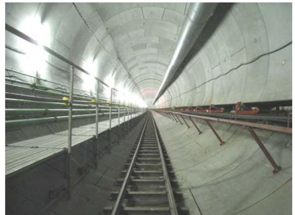
写真-1 トンネル内面状況 (SFRC セグメント箇所)
