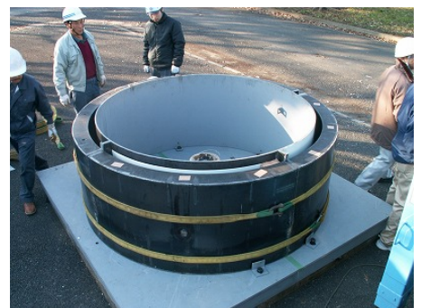
②鋼製セグメントを組立て、固定
