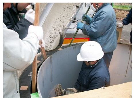
③高流動コンクリートを打設
