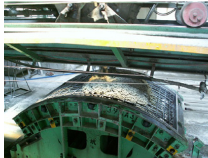
写真 - 2 生コン打設
