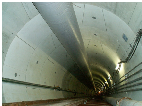
写真 - 4 CRライニングセグメント施工状況
