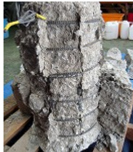
外周コンクリートを撤去
