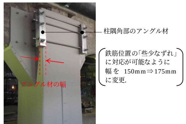
写真-1 三階部補強状況
